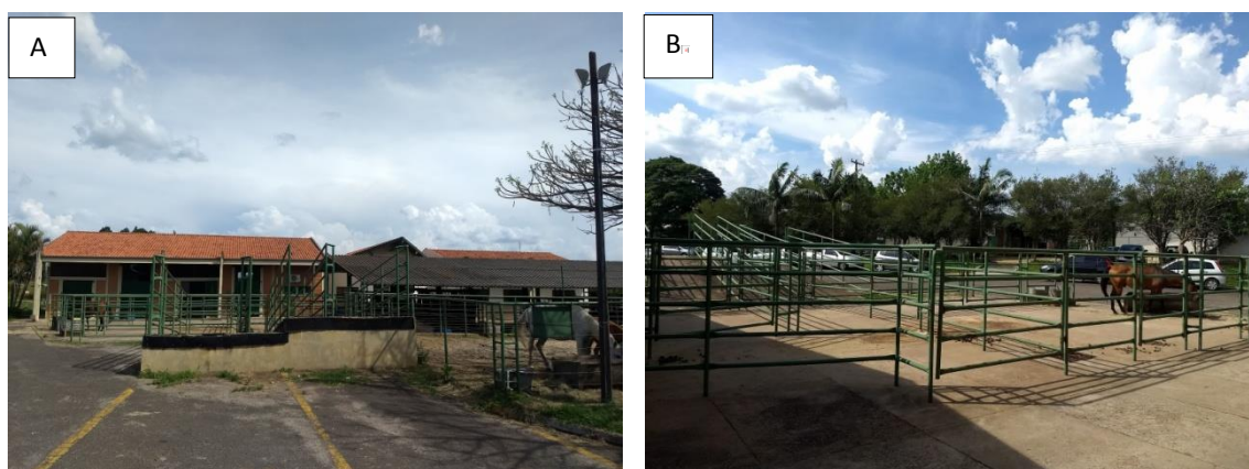
Figura 4 - Hospital Veterinário FMVZ, UNESP Campus Botucatu, setor de Clínica de Grandes Animais (CGA). A) Rampas de embarque e desembarque dos animais. B) Baías para embarque e desembarque
