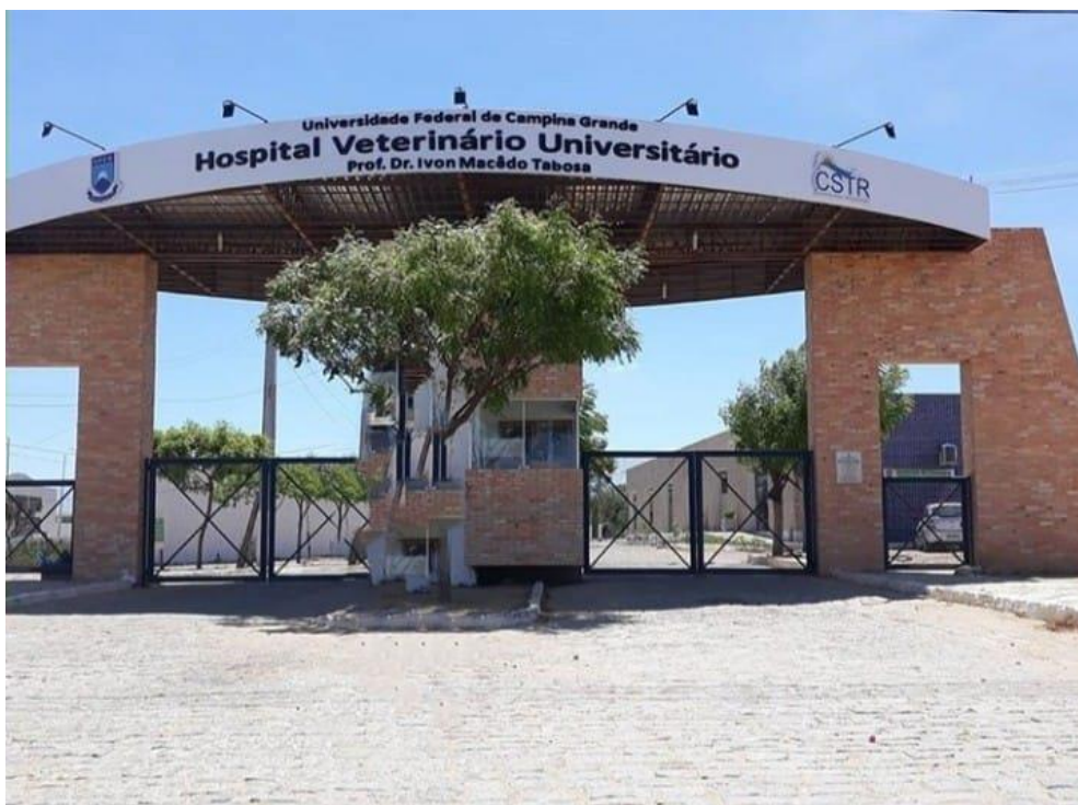
Figura 1: Fachada do Hospital Veterinário Prof. Dr Ivon Macêdo Tabosa da UFCG na cidade de Patos/PB.
