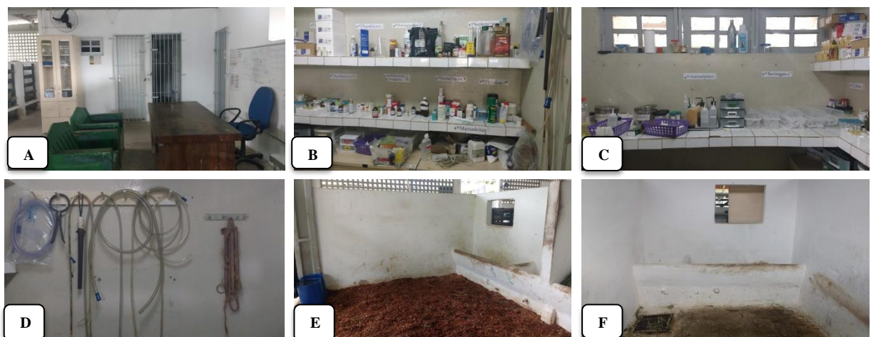
Figura 07: Infraestrutura do AGA – HOVET/UFRPE. Hall de entrada para a farmácia e as salas dos médicos veterinários (técnicos administrativos) e residentes (A); Armário no interior da farmácia contendo medicamentos (B); Armário no interior da farmácia contendo material antisséptico e seringas (C); Instrumentos de contenção e sondas (D); Baia para internação de equídeos (E); Baia para internação de pequenos ruminantes (F). Fonte: Arquivo pessoal.
