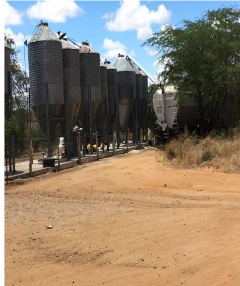
Figura 6. Silos (armazenamento de ração).
