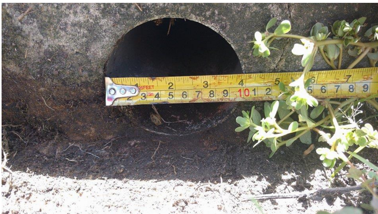
Figura 6. Estrutura implantada na área do estacionamento do Edifício Vasconcelos Sobrinho.
