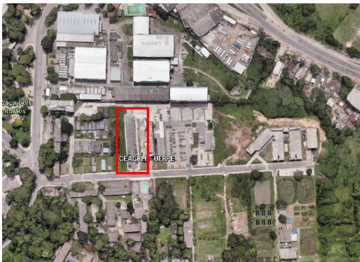
Figura 3. Área do estacionamento do Edifício Vasconcelos Sobrinho.
