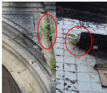
Figura 5: (a) Presença de vegetação nas fissuras dos arenitos; (b) vegetação em vergas retas.
