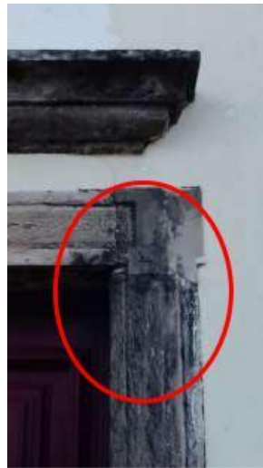
Figura 10: Intervenção restauradora com argamassa de cimento em vergas de arenito.
