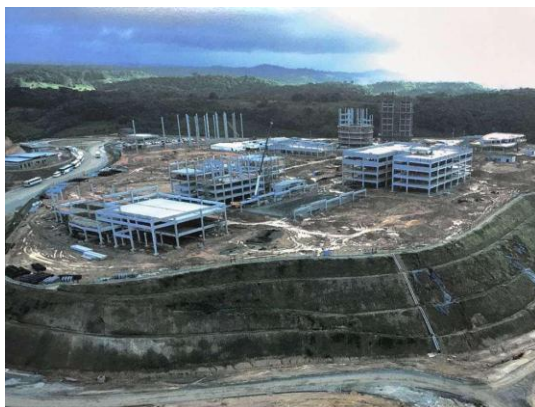
Figura 1: Fase da obra para construção do novo Campus da UACSA, julho de 2017.
