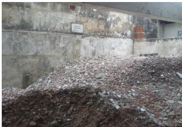
Figura 2 – Resíduos de concreto, argamassas e blocos cerâmicos prontos para serem britados.
