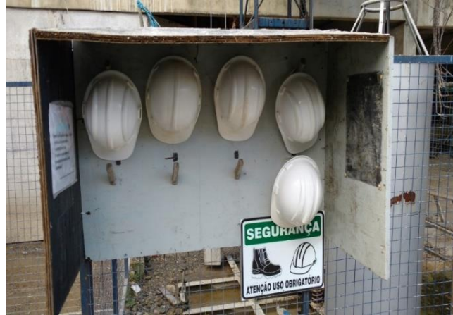
Figura 7 – Painel para suporte de EPI's fabricado com madeira reaproveitada da obra.
