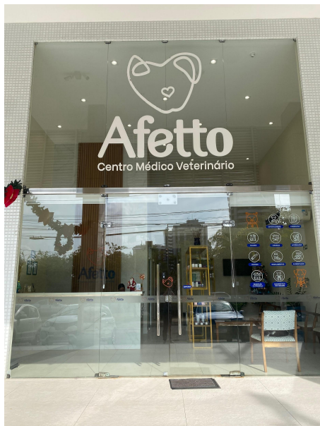
Figura 5 - Fachada externa da Afetto Centro Médico Veterinário.
