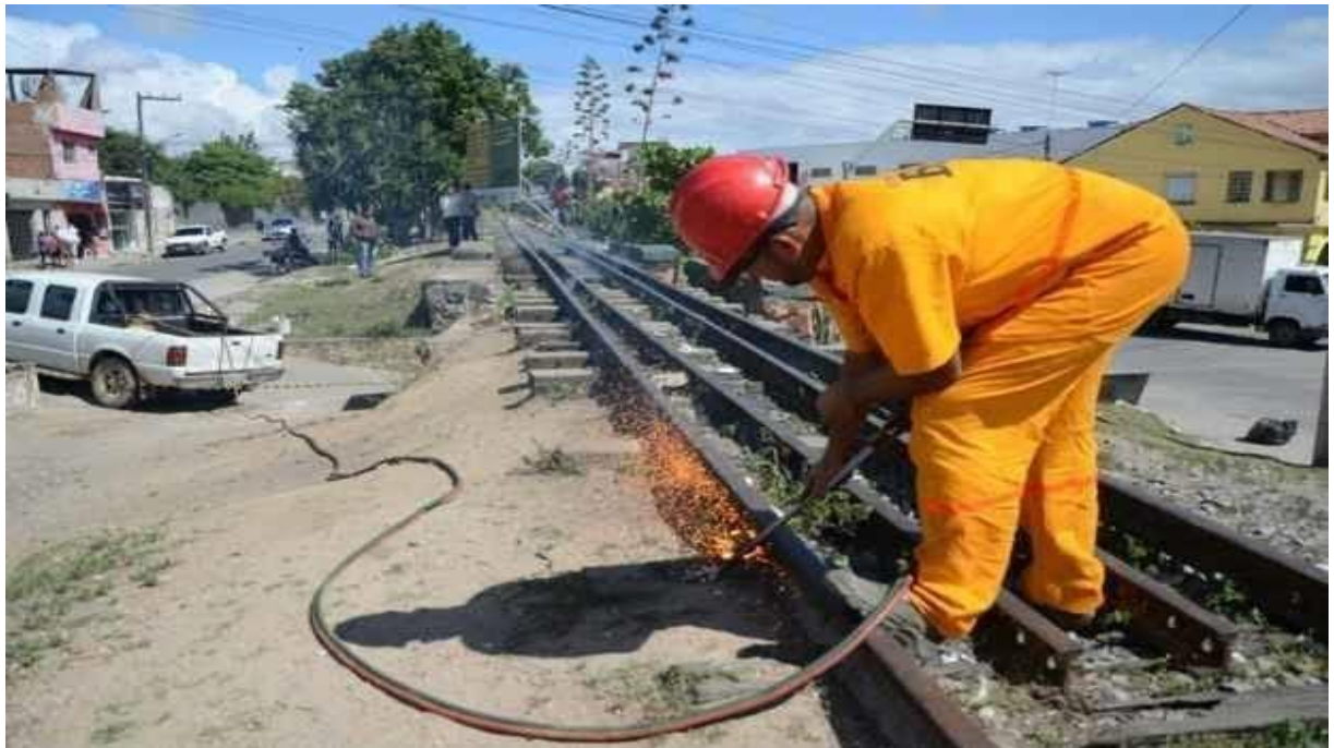
Figura 16: Momento no qual o pontilhão começa a ser retirado. Fonte: Diário de Pernambuco.
