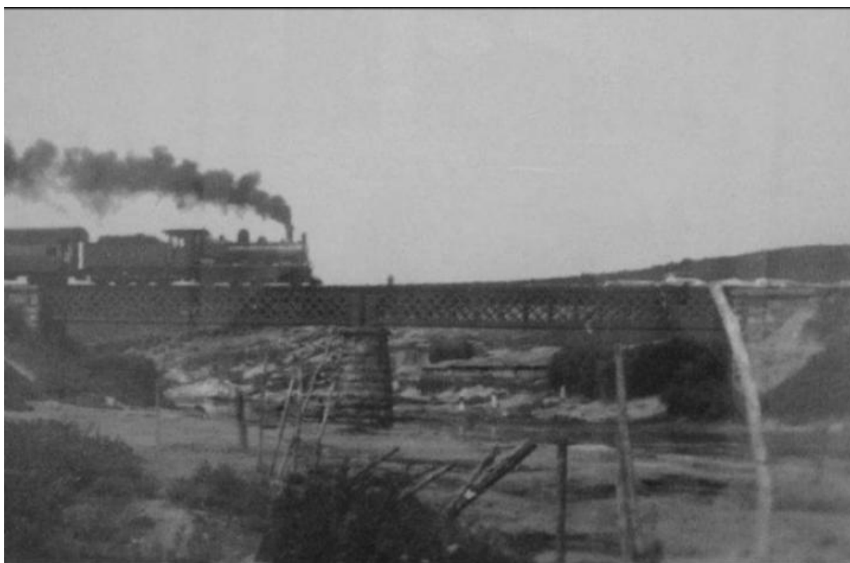
Figura 19: Locomotiva passando pela “Ponte Preta”, antiga ponte de passagem de trem em Gravatá Fonte: Grupo no Facebook: Gravatá em fotos e recordações. Facebook Gravatá em fotos e recordações.
