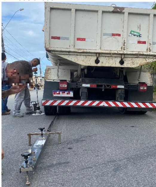
Figura 5 – Realização dos ensaios de LWD e VB lado a lado
