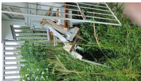
Figura 2: Acúmulo de entulhos em escola (arquivo pessoal).
