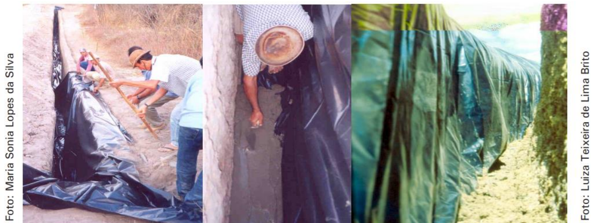
Figura 2. Prendendo a lona na superfície do terreno à jusante; e fixando a lona na base da vala à montante; lona estendida na parede da vala, à jusante da barragem subterrânea. Fonte: Silva et al. (2007a).
