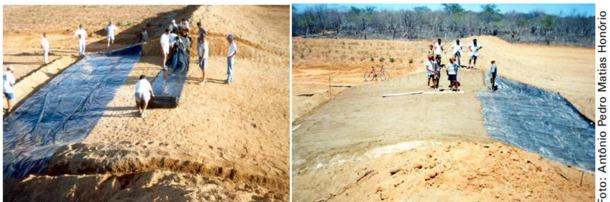
Figura 3. Colocação da lona no sangradouro e revestimento com massa de concreto. Fonte: Silva et al. (2007a).
