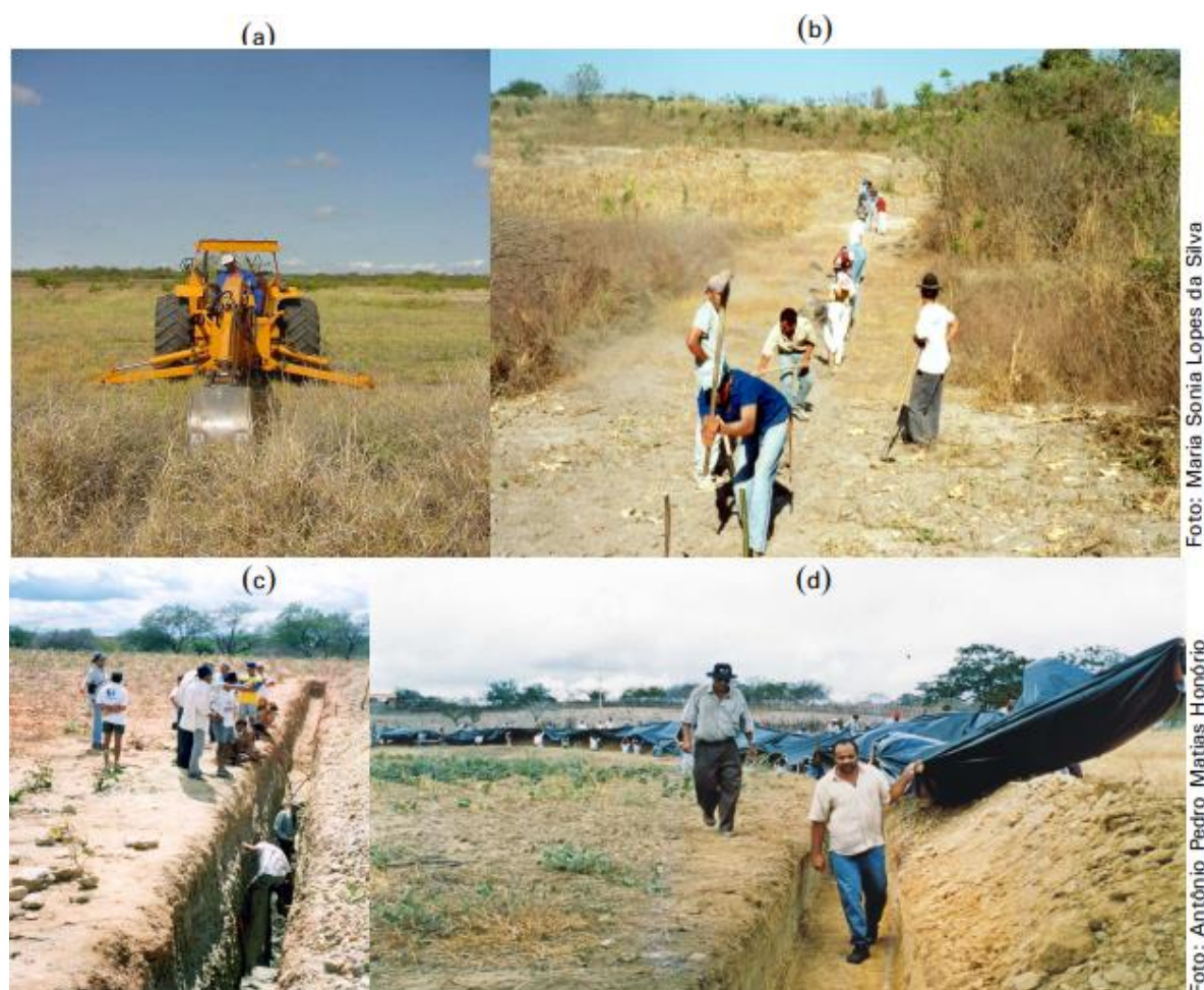
Figura 1. Abertura mecânica (a) e manual da vala (b) por onde vai subir o plástico formando a parede/septo impermeável; vala aberta até a camada impermeável ou rocha (c); lona plástica sendo estendida na vala para impermeabilizar (d). Fonte: Silva et al. (2007a).
