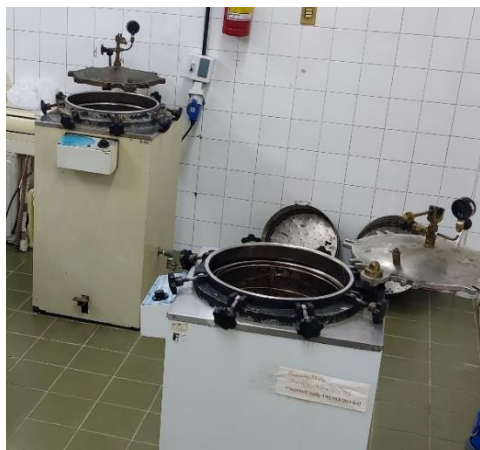
Figura 3 - Infraestrutura do Laboratório de Doenças Infectocontagiosas. Do fundo ao primeiro plano, vê-se no detalhe extintor de incêndio, autoclave de descontaminação, bandejas de autoclave e autoclave de esterilização. Fonte: Arquivo pessoal (2024).
