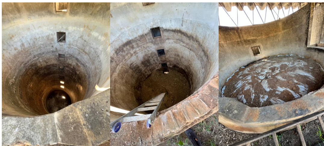
Figura 22. Silo do tipo Tubular - Vazio, na metade e cheio.
