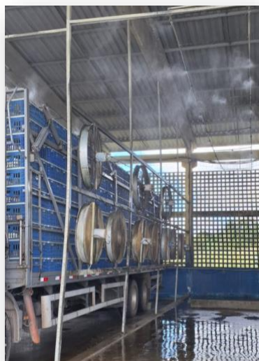
Figura 82. Nebulizadores e ventiladores da área de espera
