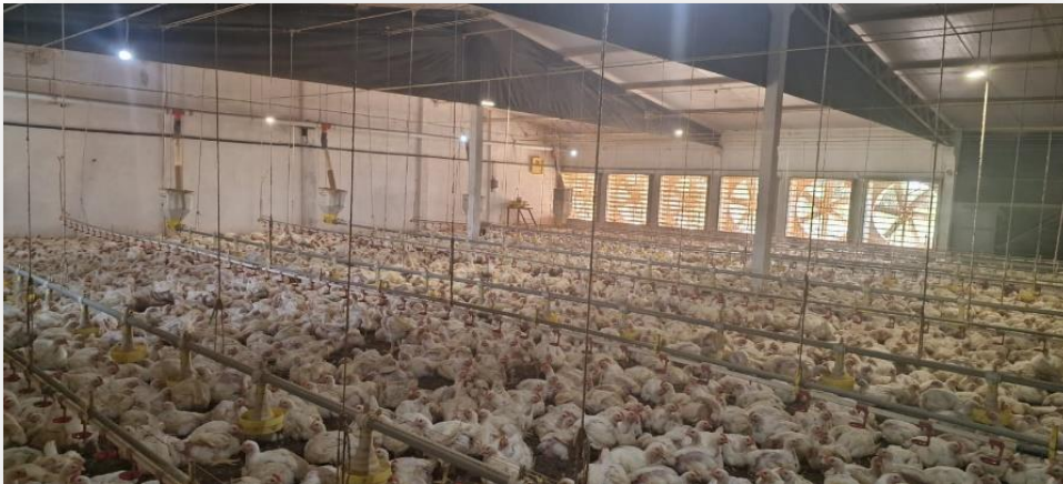
Figura 71. Galpão de pressão negativa (Fonte. Arquivo Pessoal)
