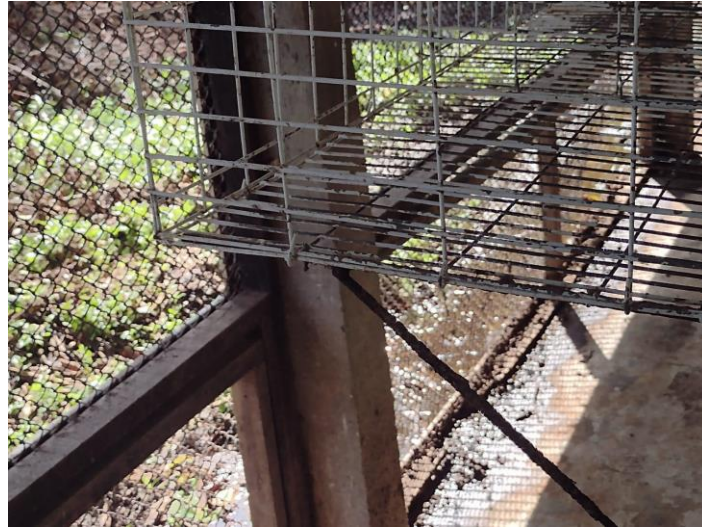
Figura 42. Lado esquerdo do galpão de postura
