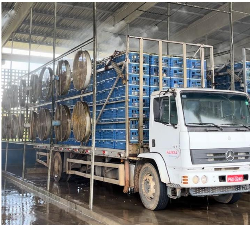
Figura 6. Galpão de espera com ventiladores e nebulizadores ligados.
