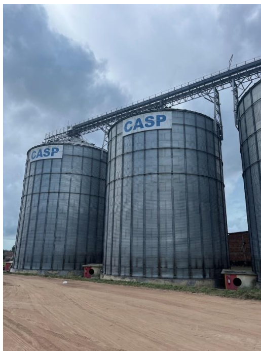
Figura 11. Silos de armazenamento de matéria prima.
