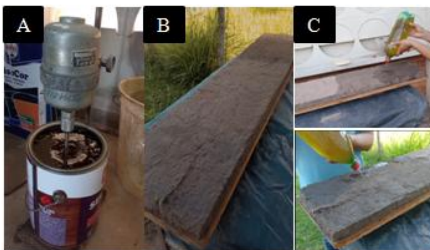
Figura 14: A) Preparação da solução, B) Macromonolito selecionado para manutenção, C) Aplicação da solução na estrutura.
