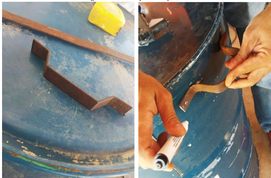
Figura 14 – Fixação de alças.
