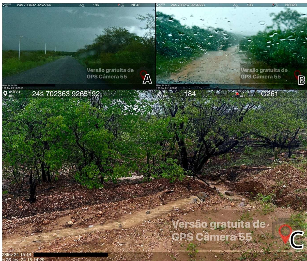
Figura 10 – Fotografia Rede de Drenagem do município de São João do Sabugi – RN.
