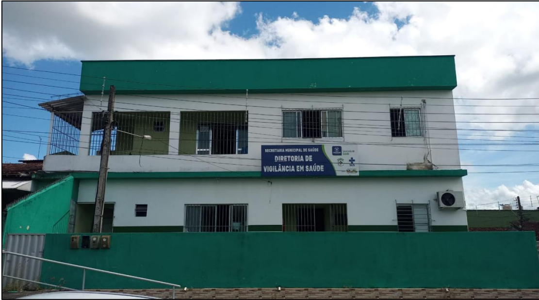
Figura 2- Fachada da Diretoria de Vigilância em Saúde de Camaragibe. Fonte: Pereira,2024.
