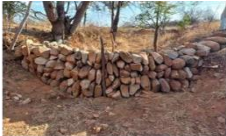
Figura 5. Barragem de Base Zero concluída.
