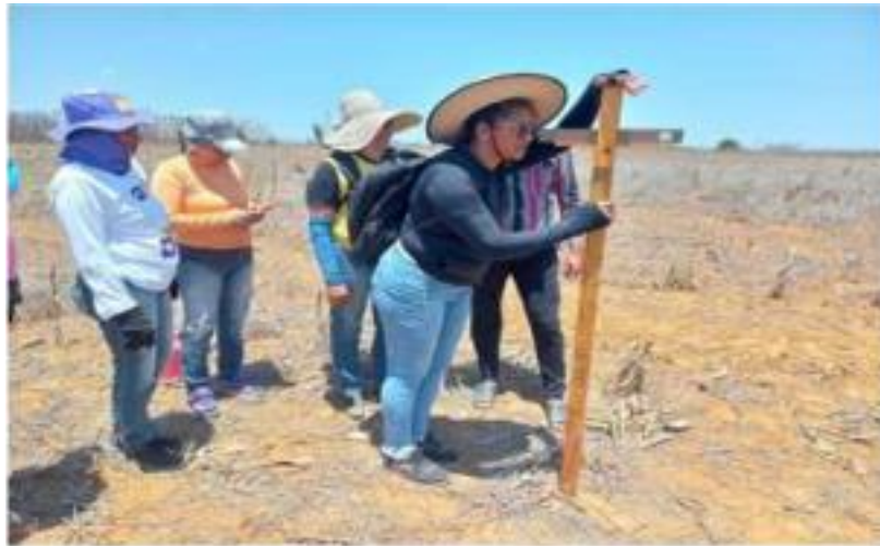
Figura 4. Marcação de curva de nível
