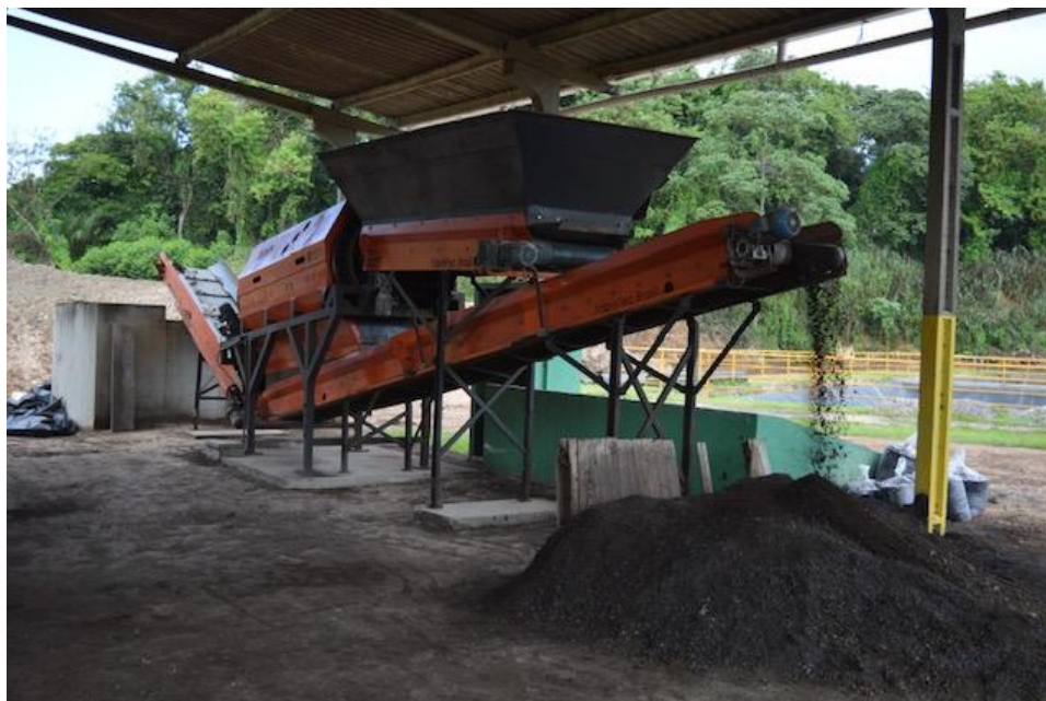
Figura 02 – Imagens da compostagem realizada no CEASA/PE.
