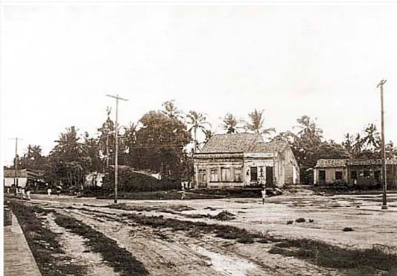
Figura 09 - Bairro do Vergel do Lago, rua Santo Antônio de descida para águas sujas em 1920
