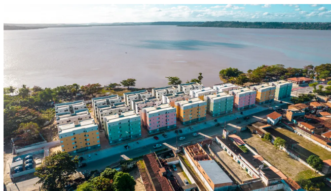
Figura 18 - Vista aérea do residencial Vilas do Mundaú à margem na lagoa mundaú, próximo área de restinga de mangue
