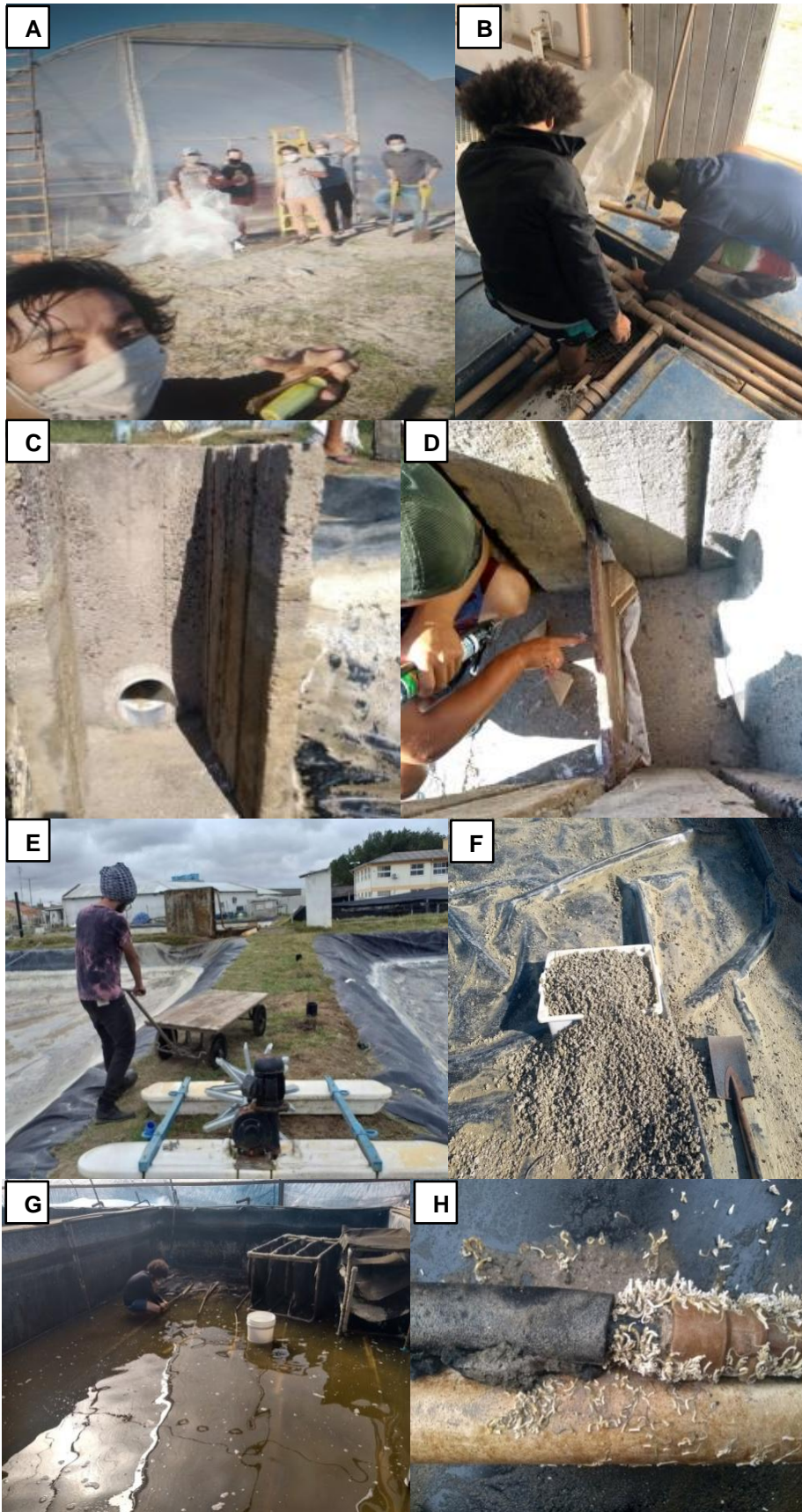
Figura 20 - Manutenção e reparos. (A) Equipe de reparos da estufa; (B) Manutenção em encanamento na sala de maturação; (C) e (D) Reposição de táboas no monge; (E) Transporte de aerador; (F) Limpeza do fundo do viveiro; (G) e (H) Desobstrução de aerotubes.
