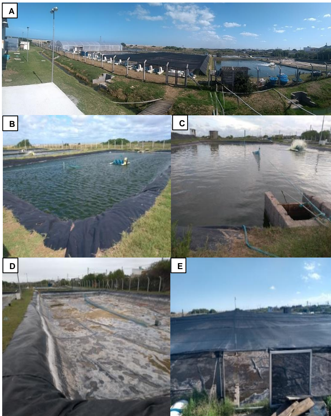
Figura 8 - Viveiros escavados (A) Vista panorâmica; (B) Viveiro cheio em plena operação; (C) Detalhe do sistema de drenagem; (D) Viveiro vazio, com o detalhamento para o forro em PEAD; (E) Vista externa de viveiro com estrutura de cobertura com sombrite.
