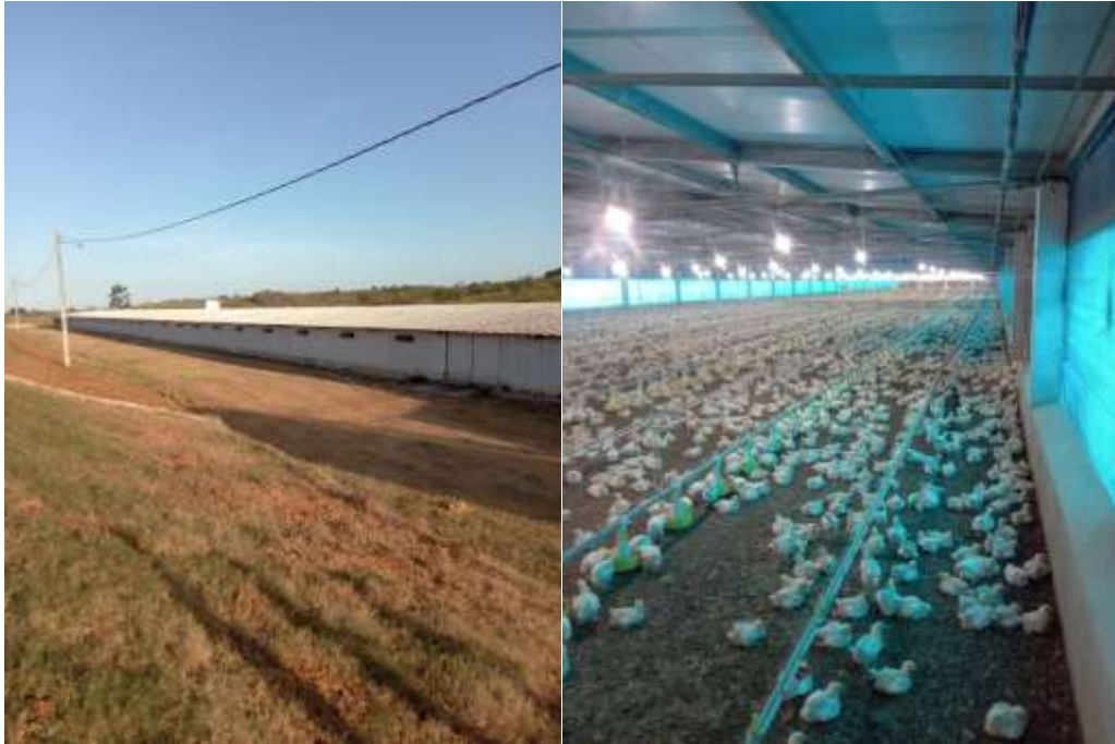
Figura 33. Galpão de pressão negativa
