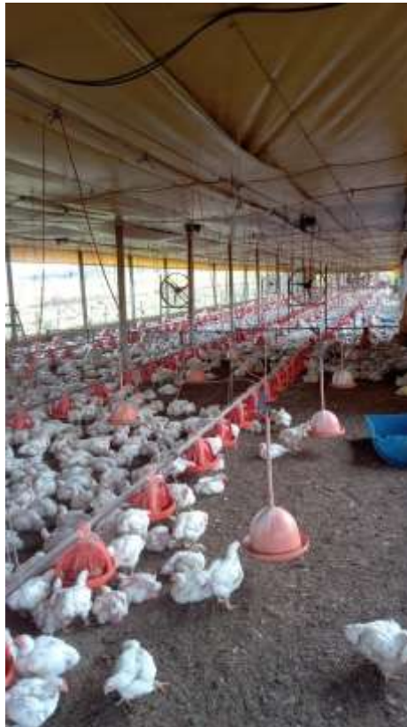
Figura 32. Galpão de pressão positiva
