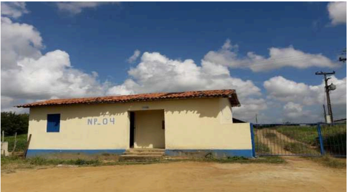
Figura 47. Entrada do núcleo 04 Fonte: Mauricéa Alimentos do Nordeste LTDA
