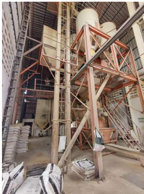
Figura 15. Silos dosadores e misturador da fábrica.
