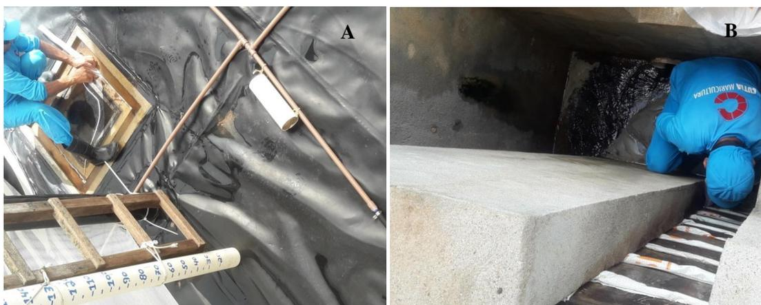
**Figura 6.** Estruturas do raceways. A - Vedação dos raceways, no local onde fica a gaiola. B - Vedação dos raceways, no local de drenagem.
