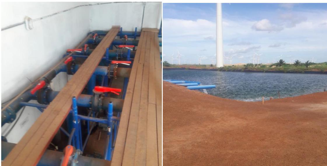
**Figura 10.** Sistema de absteçamento A - Casa de bomba para captação de água oceânica; B - Reservatório que recebe tratamento de biomix e abastece as jacuzzi com profundidade de 2 m e 20cm.
