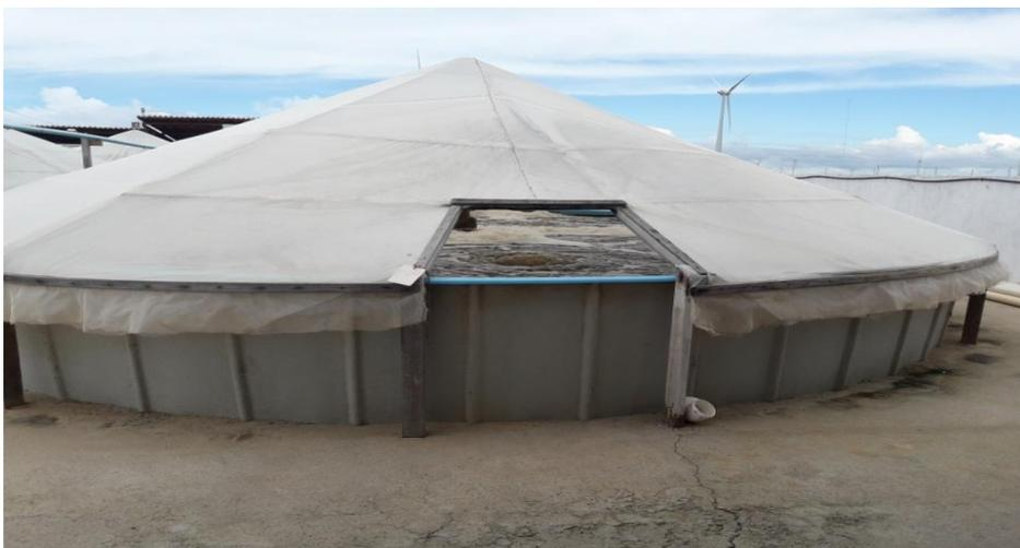
**Figura 2.** Tanque de berçário de fibra de vidro com volume de 60.000 L de água revestido com tela.
