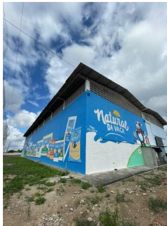
Figura 1: Fachada da fábrica de ração Natural Nutrir.
