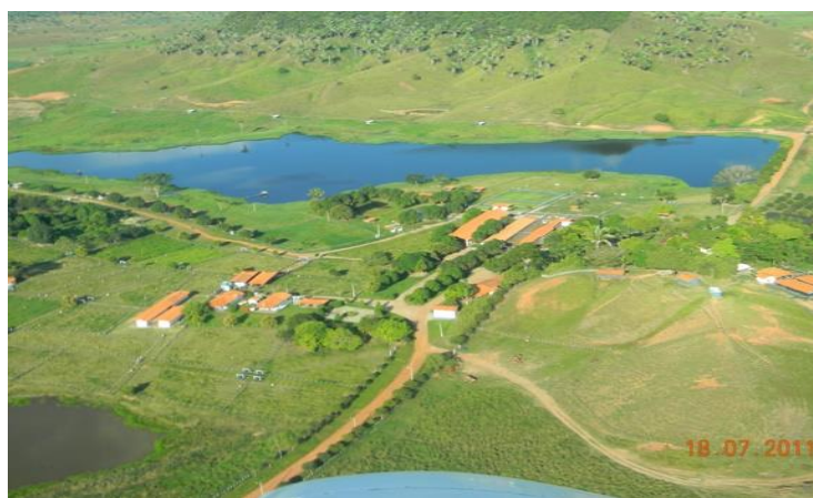
Figura 1: Foto aérea da propriedade. Fonte: http://fazendaigarape.com.br/fotos.html
