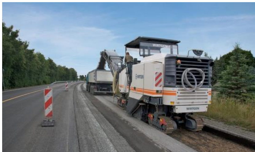
Figura 2 - Exemplo de fresadora e de serviço de fresagem em uma rodovia
