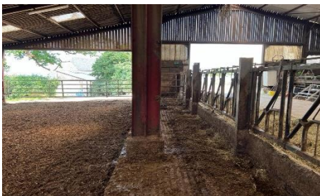
Figura 4- Galpão 2 de confinamento
