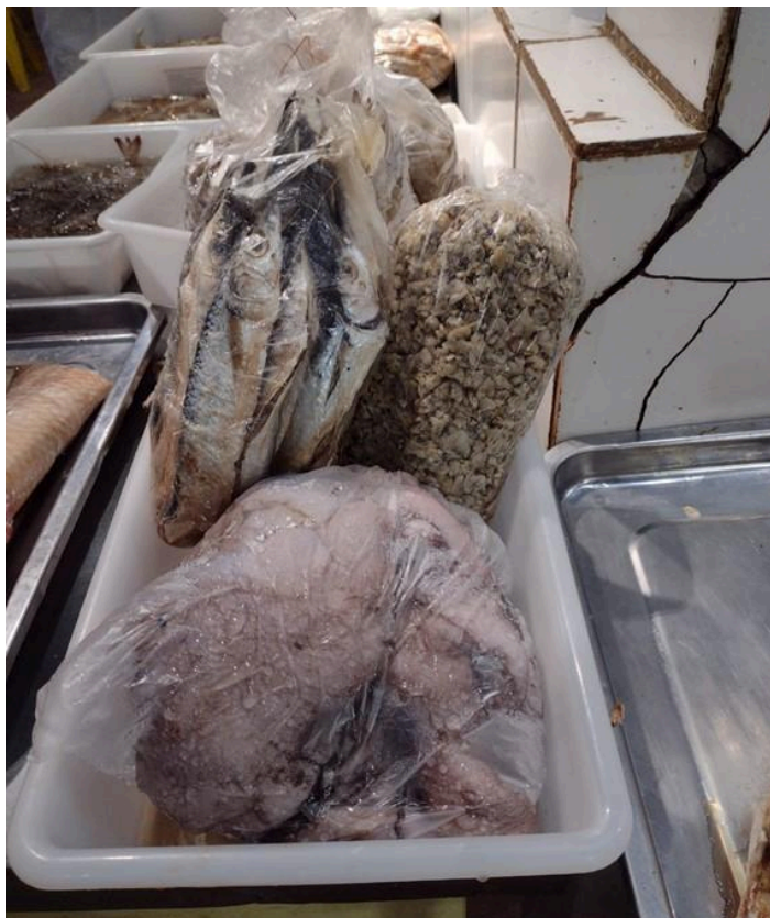
Figura 27: Aspectos da comercialização de sururu e polvo no Mercado de Boa Viagem, ao lado de agulhas. Nota-se a sujeira na parede lateral, entre as peças de cerâmica (Foto: Carolina Almeida, 2023).
