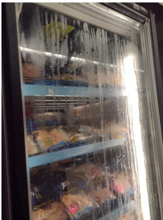
Figura 33: Freezer vertical com condensação. Foto arquivo pessoal.
