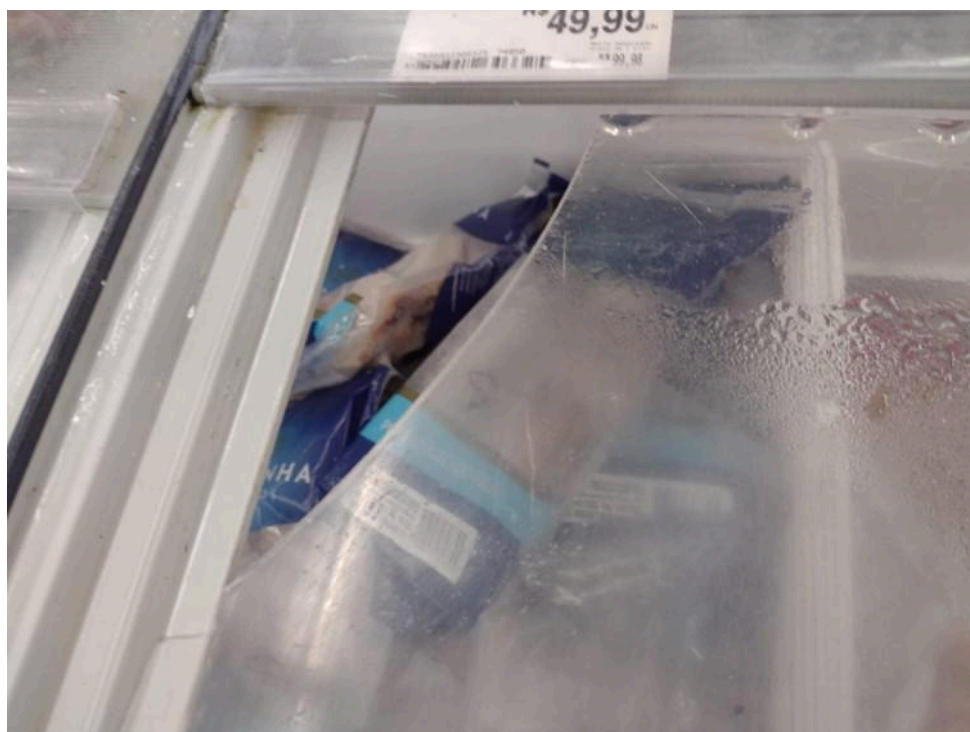
Figura 23: freezers com tampa quebrada, e sem manter a temperatura de congelamento. Foto arquivo pessoal.
