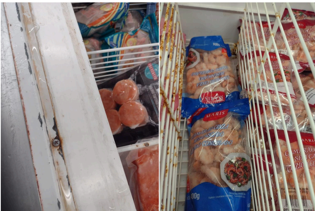
Figura 32: Freezers com peças enferrujadas em supermercados. Foto arquivo pessoal.
