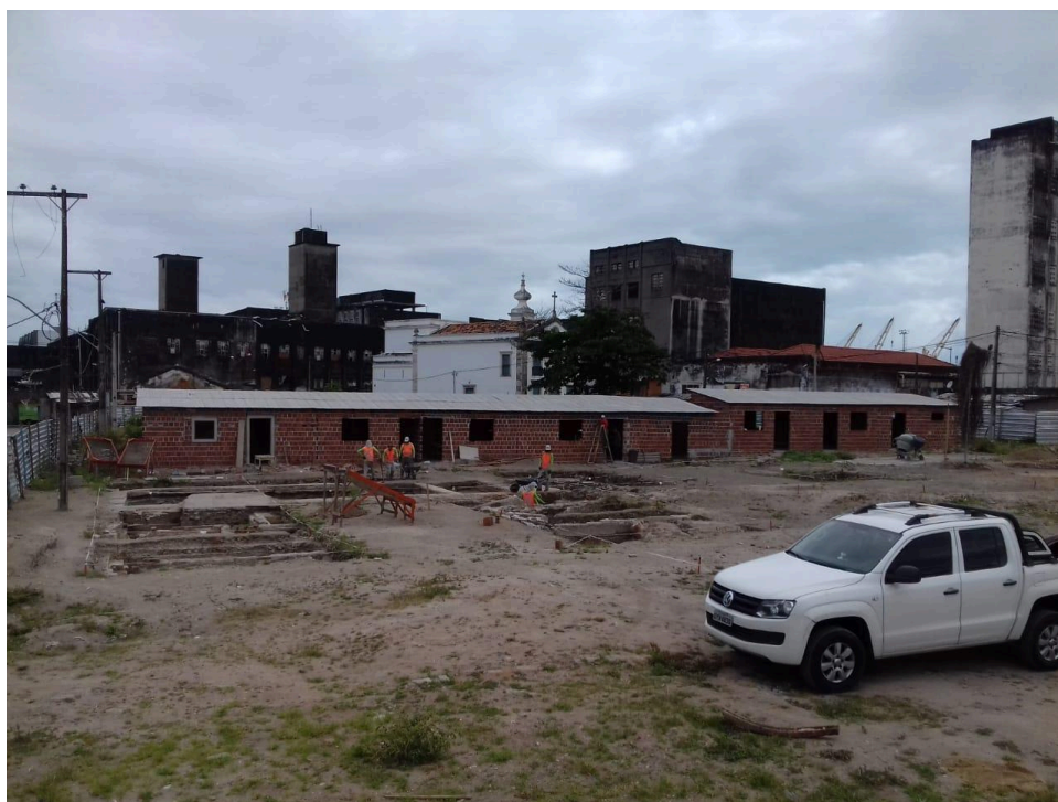
Figura 06 – Área do sítio com vista para a Igreja de Nossa Senhora do Pilar
