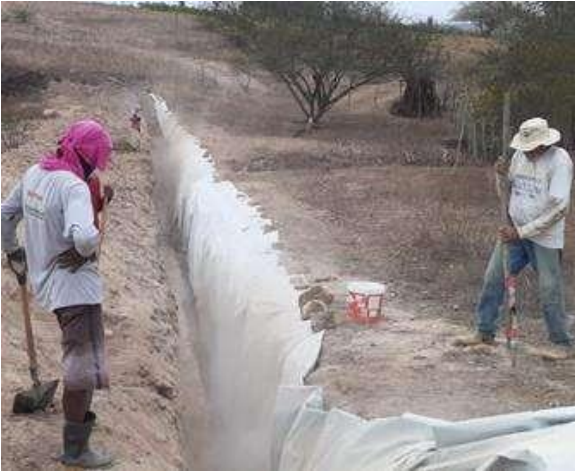
Figura 2. Parede impermeável da barragem subterrânea revestida com a lona. Foto: Fabiano Damasceno.
