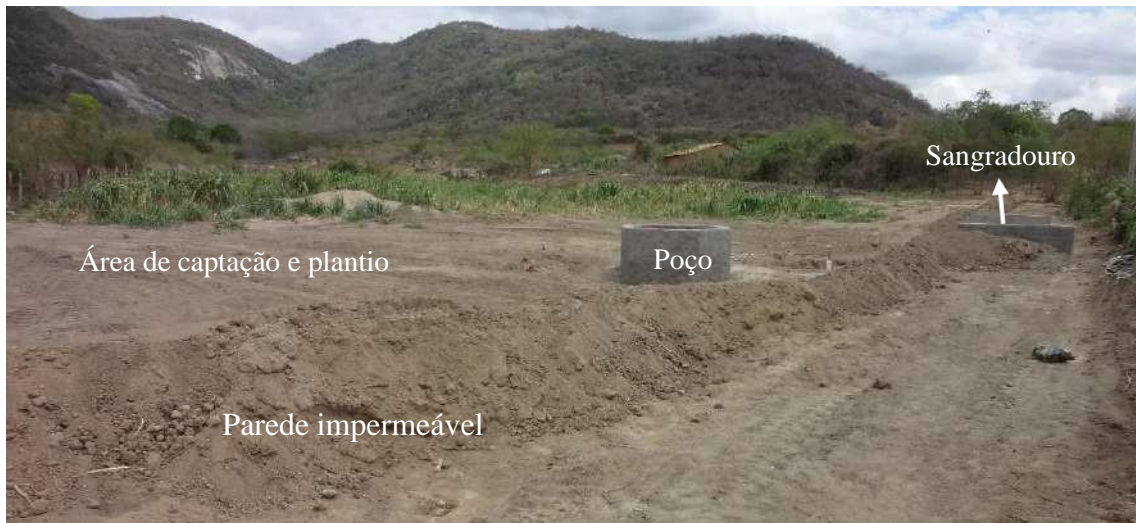
Figura 6. Barragem subterrânea submersível. Foto: Maria Sonia Lopes da Silva.
