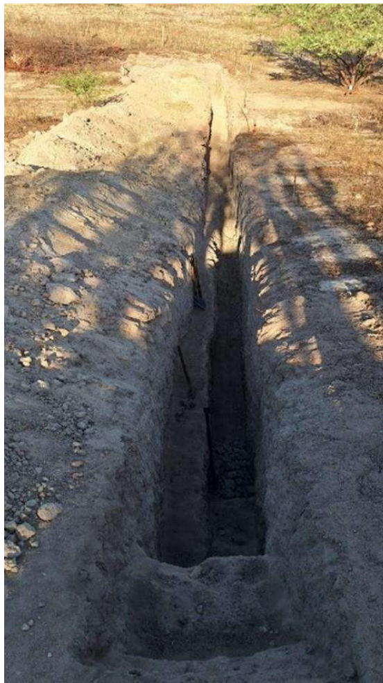
Figura 1. Vala aberta para a colocação do plástico, que constitui a parede impermeável da barragem subterrânea.
