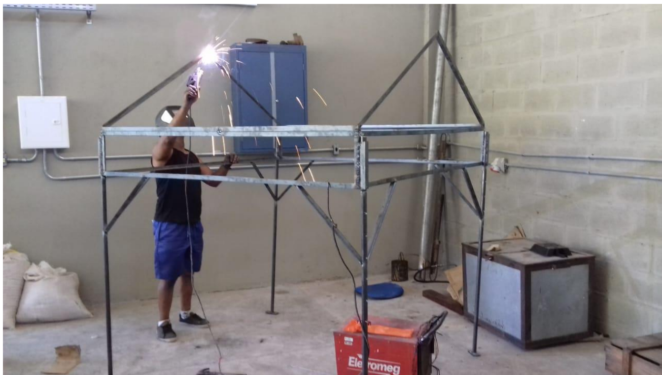
Figura 17. Processo de solda das ferragens.
