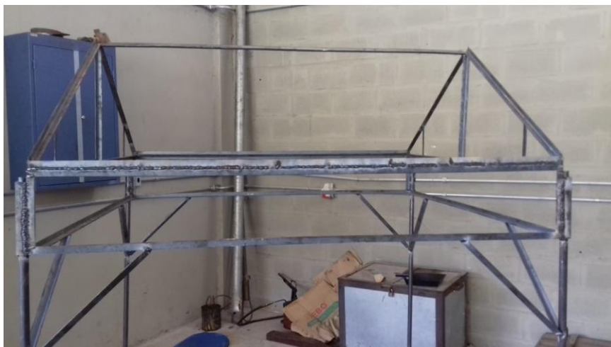
Figura 5. Dessalinizador solar plano construído.
