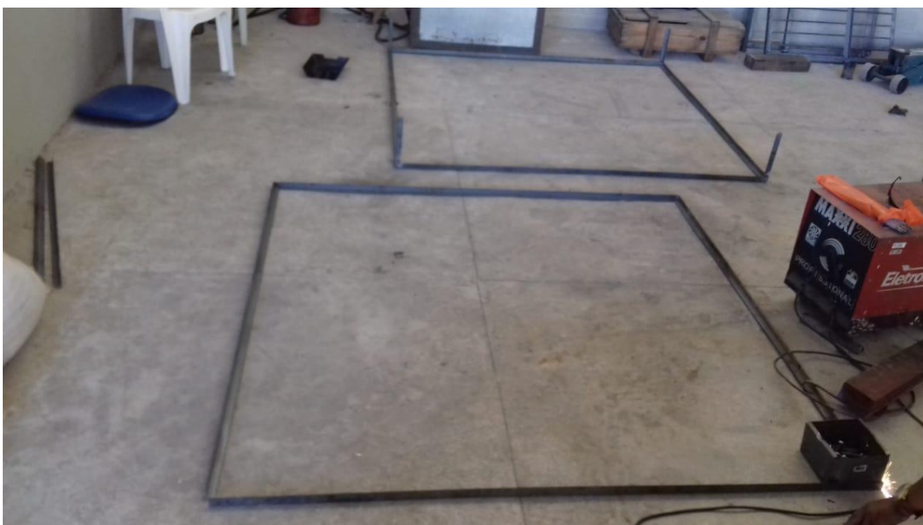
Figura 14. Continuação do processo de construção do dessalinizador solar plano.
