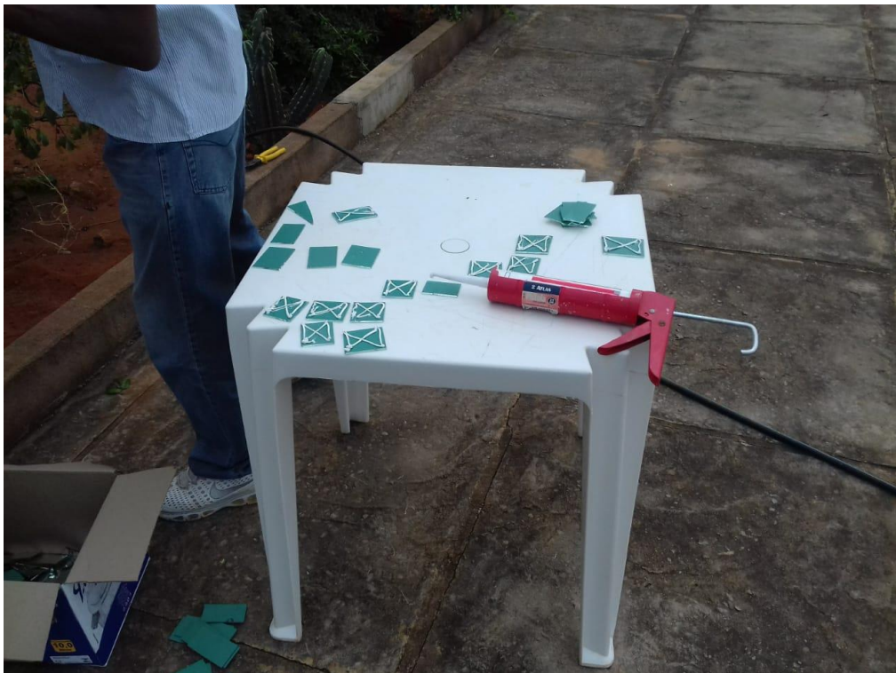
Figura 8. Aplicação de cola fixa espelho.
