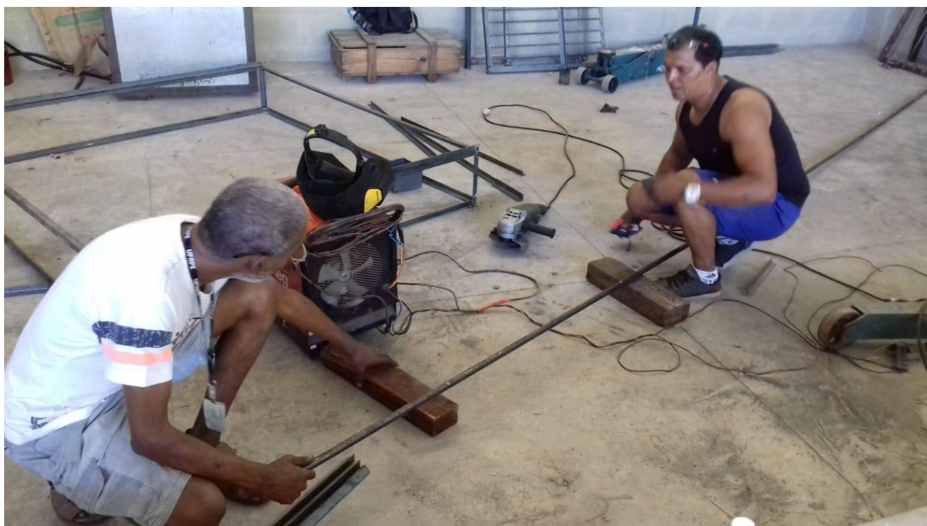
Figura 16. Equipe realizando a conferência das medidas das ferragens.
