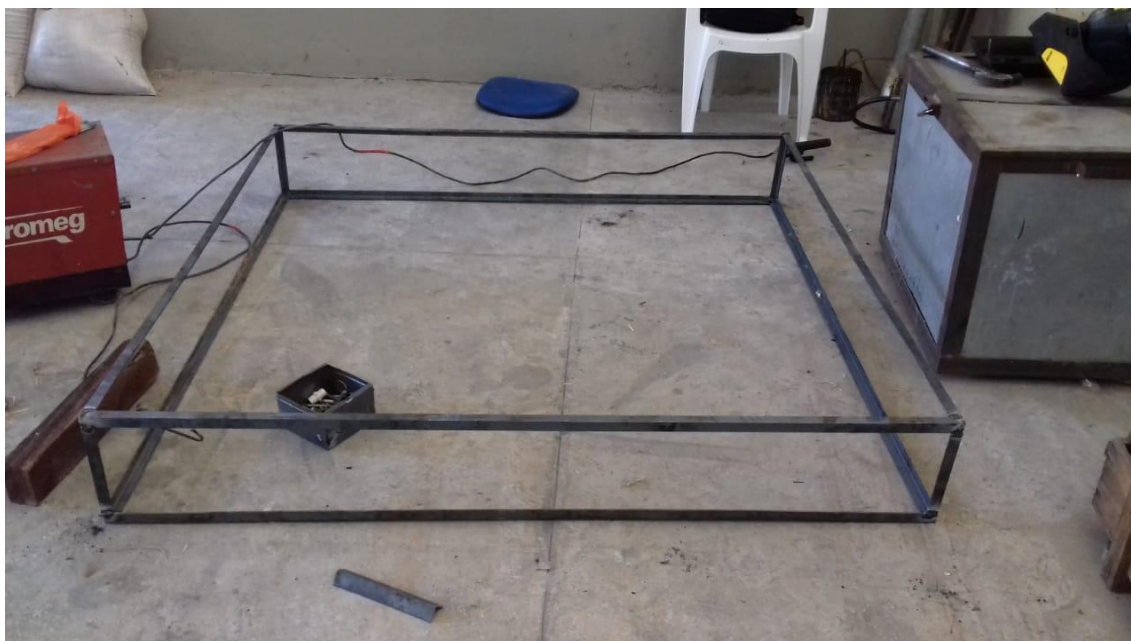
Figura 15. Base do dessalinizador solar plano concluída.
