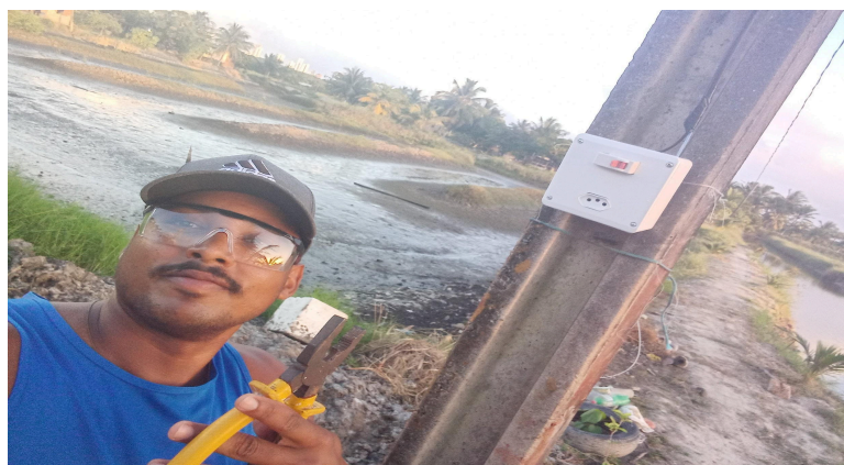
Figura 3: Instalação de tomadas dos aeradores no subsistema
