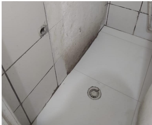
Figura 2- Ralo da instalação sanitária do E2.
