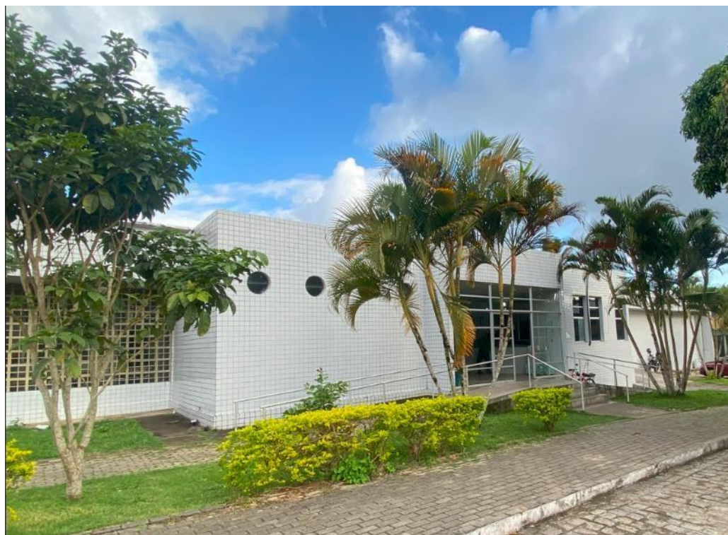
Figura 10: Entrada principal do Hospital veterinário da UFPB/Areia-PB.
