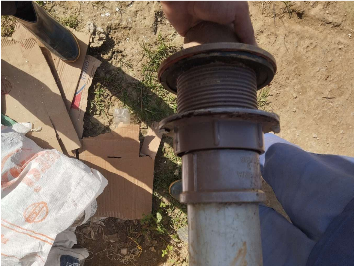
Figura 15 acoplamento 75 mm entre o tubo roscável e flange
