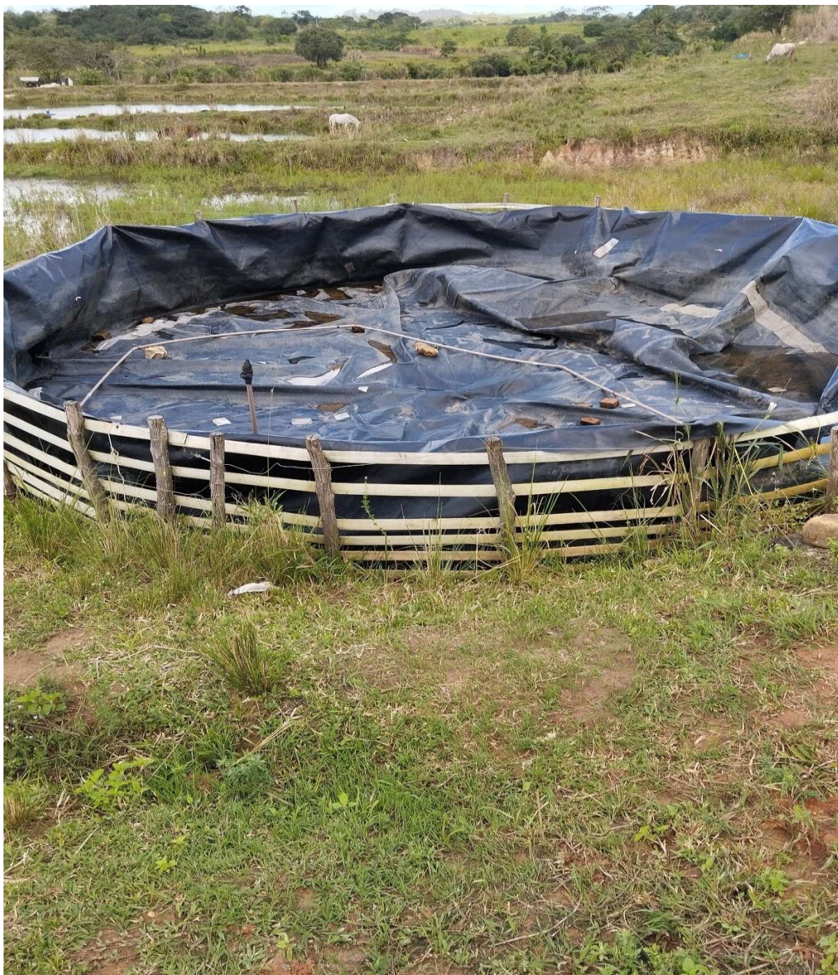
Figura 16 Berçário circular revestido com geomembrana 0,8mm
