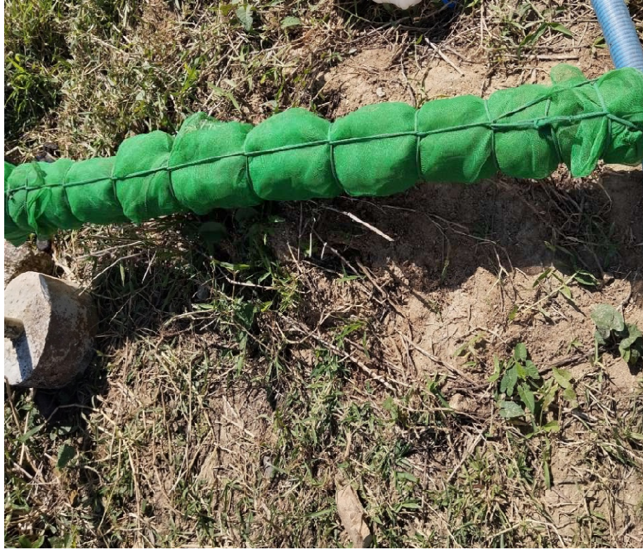
Figura 6. Cano de pvc utilizado para abastecimento dos viveiros com telas com malha de 1mm para filtração da água
