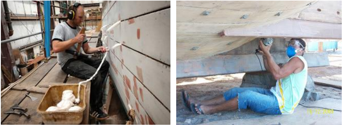
Figura 11. (A) calafetagem realizada com “fio” (B) acabamento
