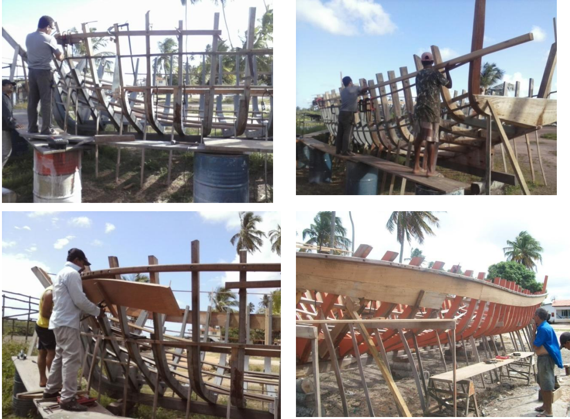
Figura 7. (A) instalação do cintado, (B) cintado de proa a proa (C) primeira tabua do cintado (C) tabuado inferior com cintado de fora a fora.
