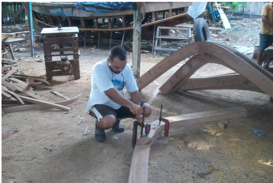
Figura 4. Corte da madeira em curva e emenda para construção de uma costela.
