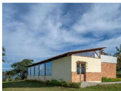
Figura 2: Vista lateral da fachada principal.
