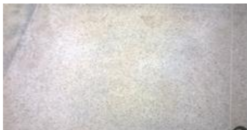
Fig. 27 – Revestimento de pisos
