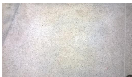
Fig. 16 – Revesimento de piso
