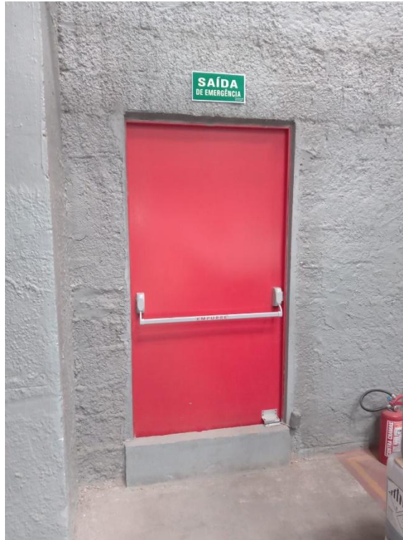
Figura 8 – Saída de emergência
