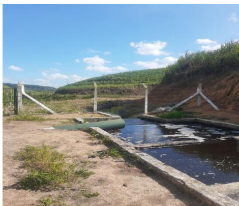
Figura 40. Caixa de recebimento da vinhaça na estação e canal dos engenhos Recreio e Mussu.
