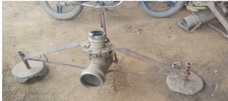
Fig. 30: Subida para aspersor/ sapata.
