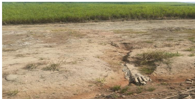
Figura 46. Sistema de drenagem com bambus
