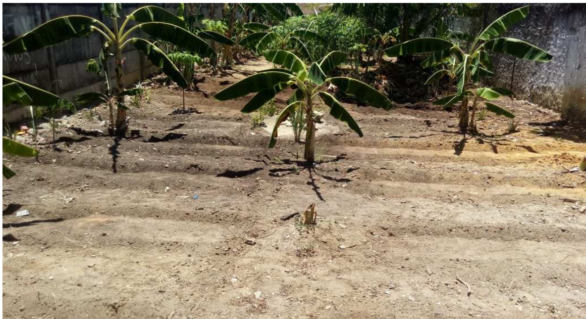
Foto 1. Limpeza do terreno
