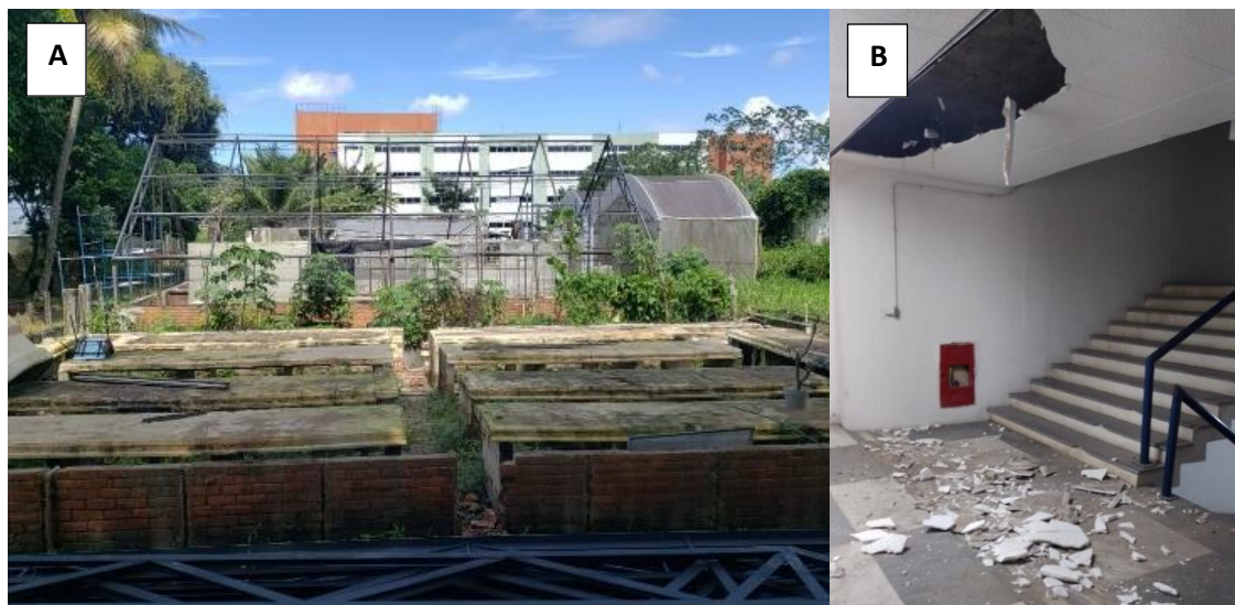
Figura 10 – (A) Casa de vegetação do laboratório de Fitobacteriologia da UFRPE desmontada para reforma. (B) Desabamento do gesso do teto do prédio Otávio Gomes.
