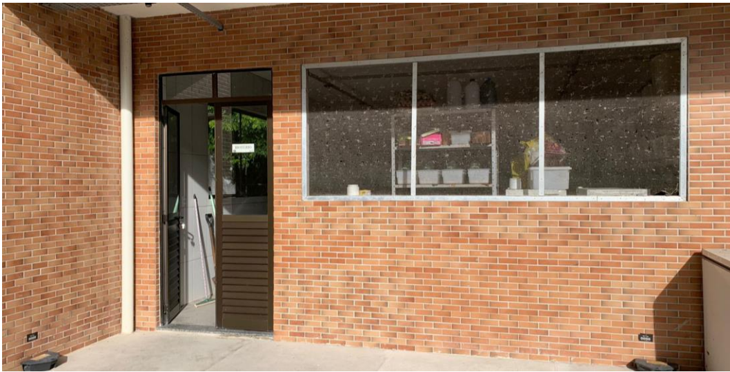
Figura 03: Entrada do Biotério do PEDI. Local conta com grandes janelas telas, que favorecem a entrada da luz natural, além da circulação dos ventos. Fonte: Arquivo pessoal.
